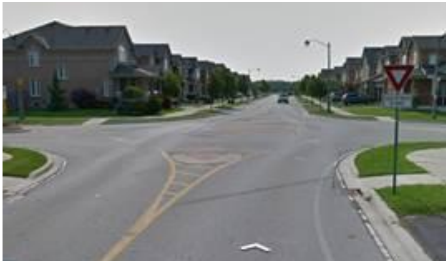
Figure 9: Mini Roundabout
