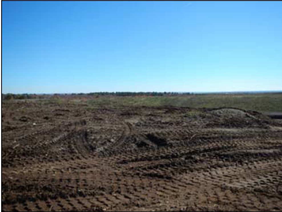
Photo 45. Active Landfill, Area E1
